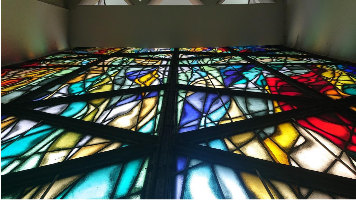
5. Odkształcenia (wybrzuszenia do środka) ram witraża (A, B, C, D).
